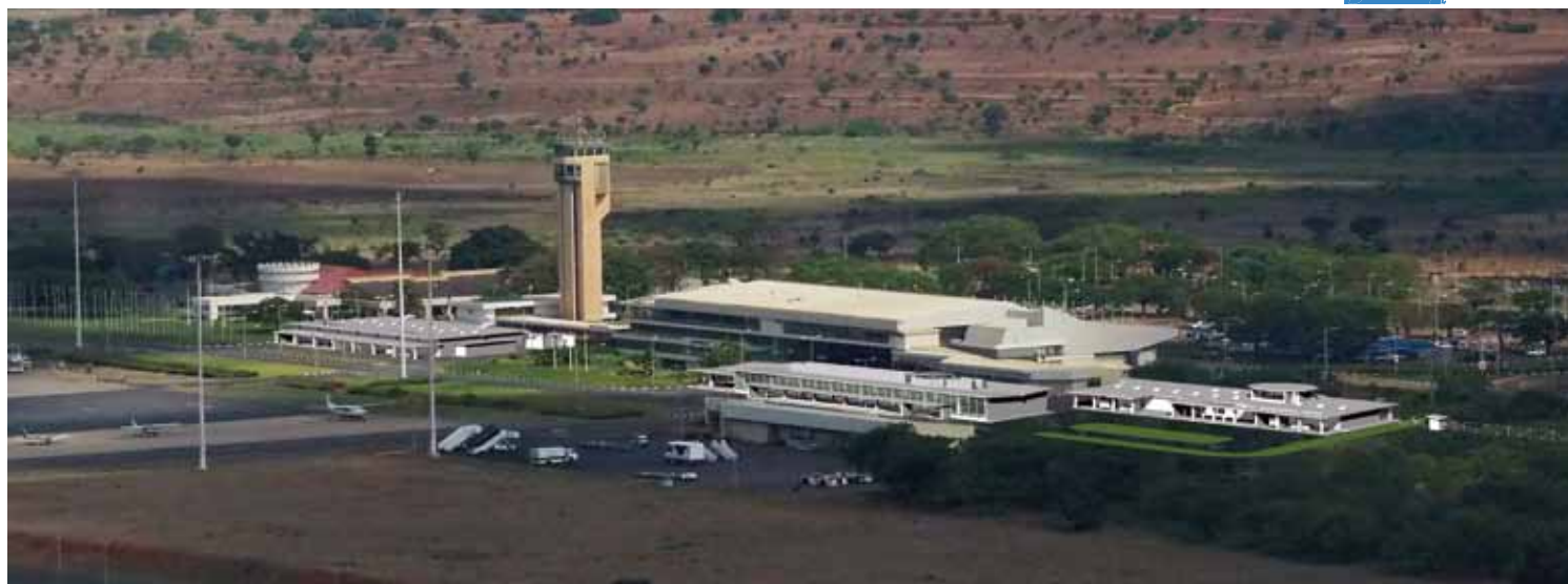
ターミナルビル拡張・改修後のカムズ国際空港
